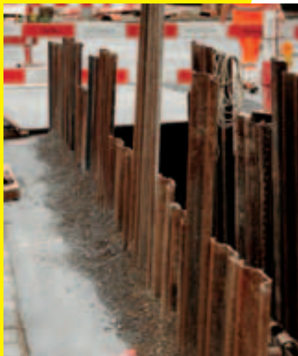
4 Nessuna caduta di materiale nello scavo.
