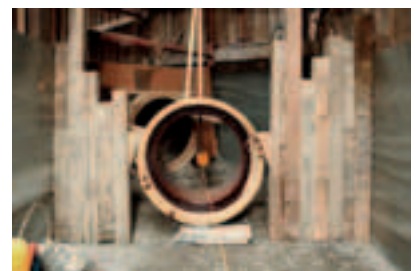
7 Larghezza dello scavo dimensionata correttamente.
