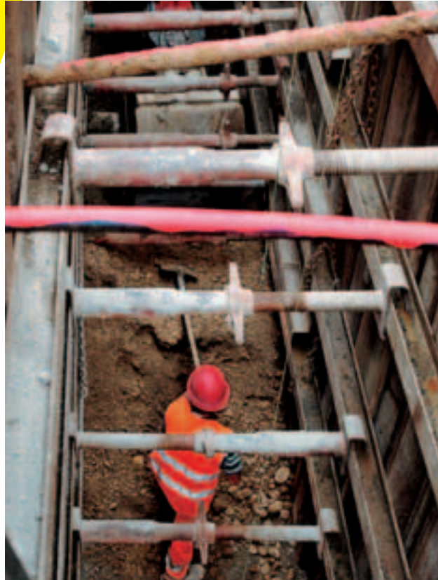
5 Dimensionare correttamente puntelli e sbadacchi.
