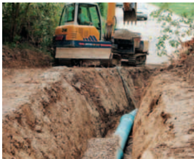
9 Scarpare o sbadacchiature obbligatorie a partire da 1,5 m.
