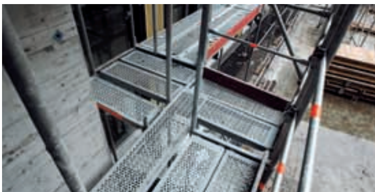
10 Ponteggi collegati in modo continuo.
