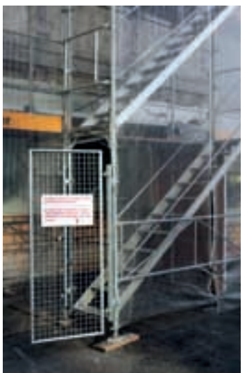
7 Accesso sicuro al ponteggio.
