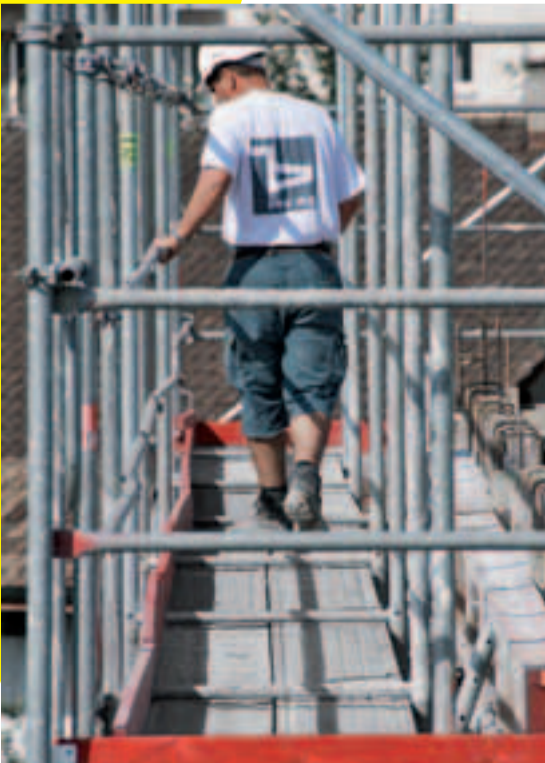
7 Piano di calpestio libero nei ponteggi.
