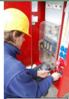
Armoire de chantier
