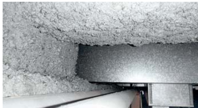
Rivestimento antincendio su travi di acciaio
