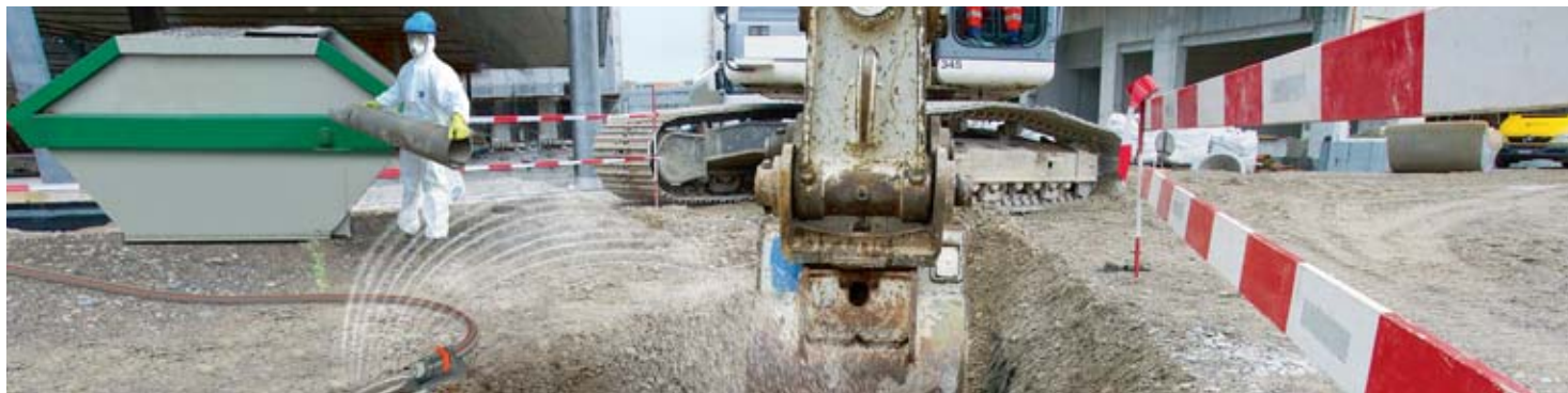
Smantellamento di condotte
