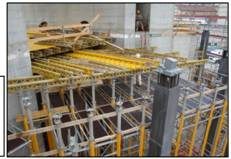
Casseratura convenzionale con il sottostante ponteggio di superficie
