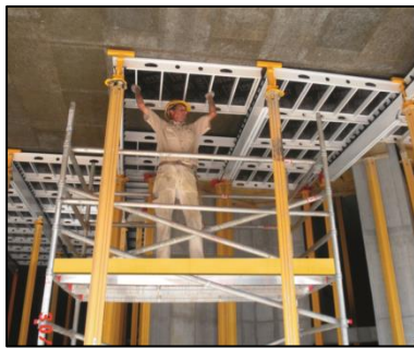
Casserare, risp. scasserare dal disotto per mezzo di ponteggio mobile e/o cassero modulare
